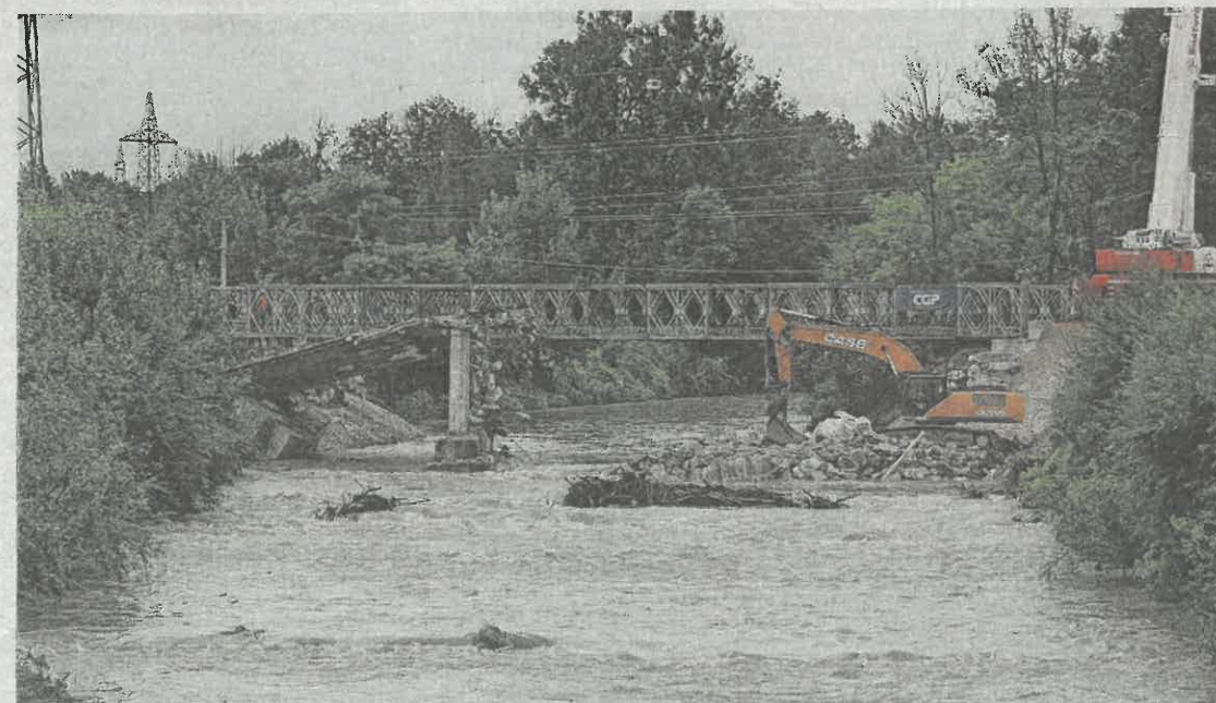
Montažna mostova na Vidmu so postavili gorvodno od porušenega.
