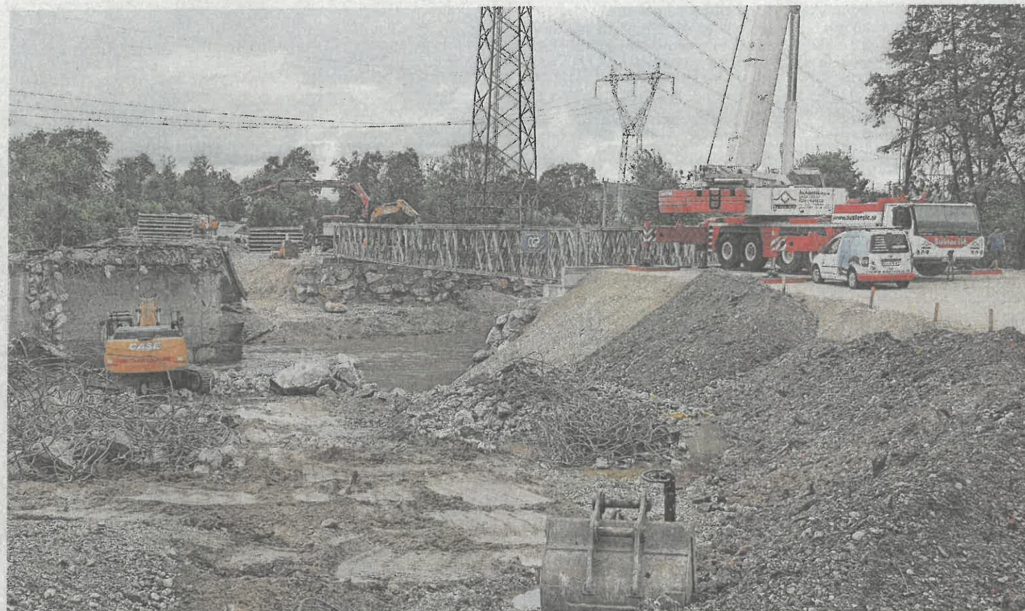
Gradbinci zdaj hitijo z ureditvijo cestnih dovozov na montažna mostova čez Kamniško Bistrico na Vidmu. FOTOGRAFIJE BOJAN RAJŠEK
